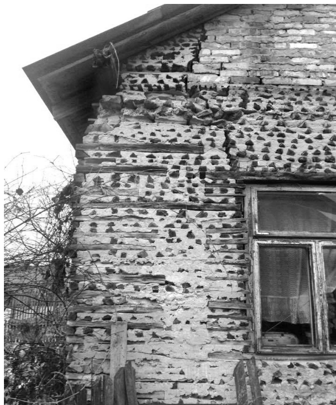
Ryc. 10. Budynek z polan opałowych w Brykach; fot. M. Kurnicka, 2015 Fig. 10. The cordwood masonry house in Bryki; photo by M. Kurnicka, 2015
