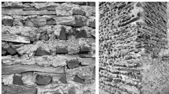
Ryc. 5. Ujęcia konstrukcji ścian budynku z polan opałowych w Mścichach; fot. N. Pietruszewicz, 2015
