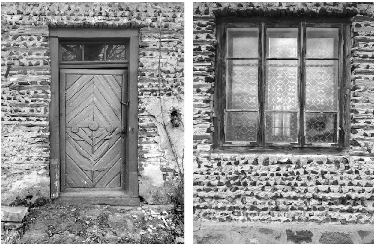
Ryc. 6. Budynek z polan opałowych w Mścichach – węgry i nadproża ; fot. N. Pietruszewicz, 2015 Fig. 6. Cordwood masonry walls in the house in Mścichy; photo by N. Pietruszewicz, 2015
