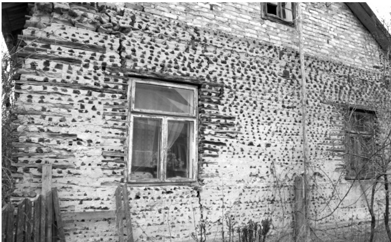
Ryc. 9. Budynek z polan opałowych w Brykach; fot. M. Kurnicka, 2015 Fig. 9. The cordwood masonry house in Bryki; photo by M. Kurnicka, 2015
