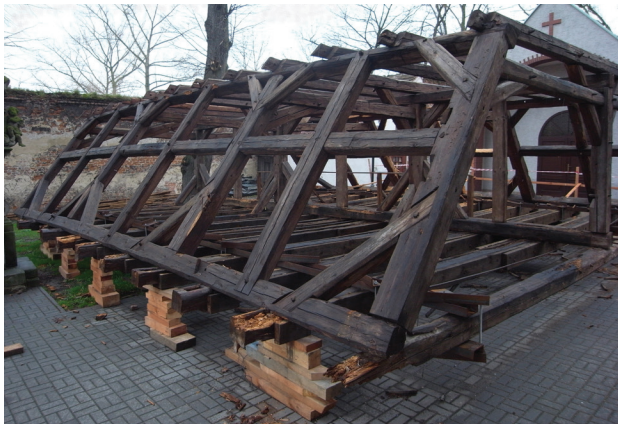
Il. 8. Część dolna usuniętej konstrukcji dachowej nad nawą główną kościoła w Ujeździe (fot. M. Warchoł)
