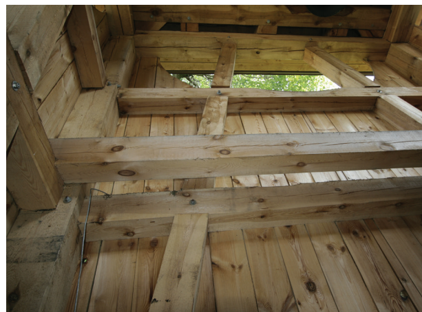
Il. 9. Odtworzona konstrukcja ciesielska dzwonnicy w Nadarzynie (fot. M. Warchoł)
