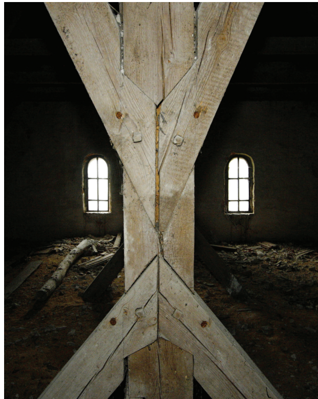
Il. 3. Sposób obróbki elementów więźby dachowej kościoła w Pawłowie Kościelnym (fot. M. Warchoł)
