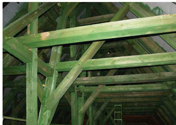
Il. 7. Odtworzona konstrukcja dachu kościoła pw. św. Jana we Włocławku (fot. P. Tuliszewski)
