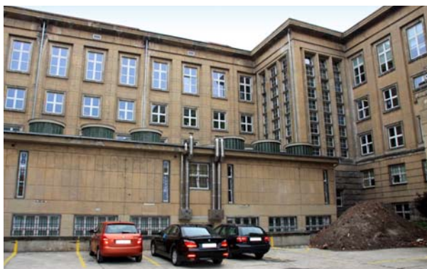
Ryc. 11. Widok elewacji dziedzińca wewnętrznego budynku D1. W oprawie kamieniarskiej wykonane są jedynie obramowania okienne i fragmenty cokołu. Reszta elewacji jest tynkowana w sposób imitujący kamień. Fot. J. Piskozub, 2012 r.
