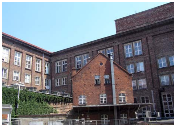
Ryc. 14. Widok elewacji budynku D2 od strony dziedzińca wewnętrznego – porzuconych w trakcie realizacji i niedokończonych od 60 lat. Fot. J. Piskozub, 2012 r.
