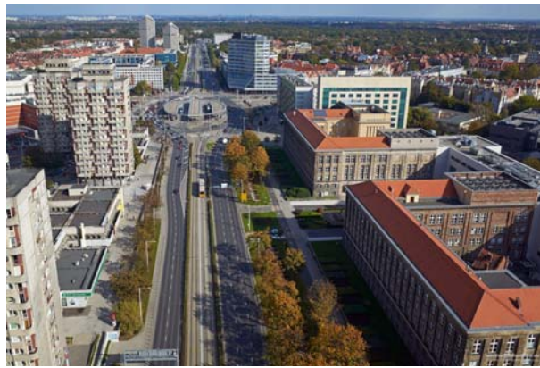
Ryc. 16. Widok Osi Grunwaldzkiej oraz budynków Wydziału Elektrycznego i Lotniczego (dawna nazwa) – stan z roku 2014 (elewacje gmachu D1 od strony dziedzińca wewnętrznego – po renowacji). Źródło: Internet [4], nr rejestru 606430
