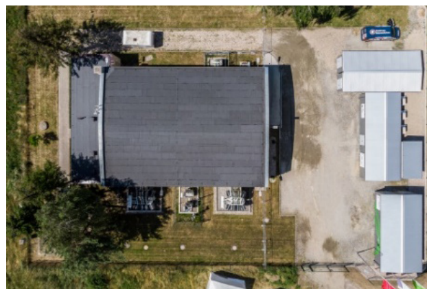
Rys. 4. Widok z góry na magazyn energii (po prawej) położony obok podstacji trakcyjnej Garbce (po lewej) (źródło: materiały PKP Energetyka S.A.)
