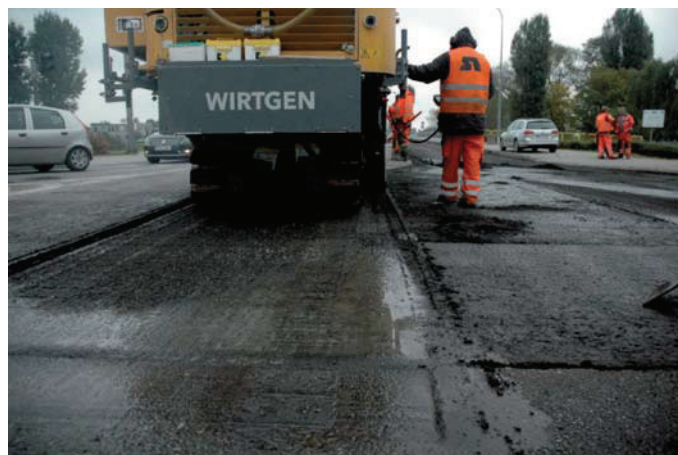
Fot. 9. Frezowanie warstwy ścieralnej nawierzchni
