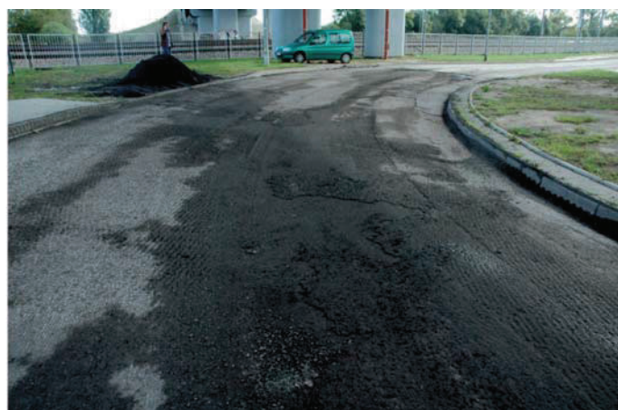
Fot. 17. Wykruszenia, luźne ziarna po środku lewej strony drogi
