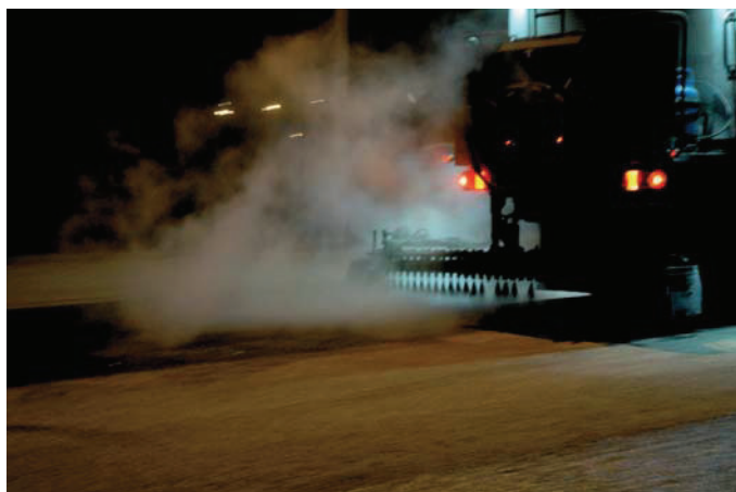
Fot. 11. Skrapianie powierzchni emulsją asfaltową przed układaniem kolejnej warstwy
