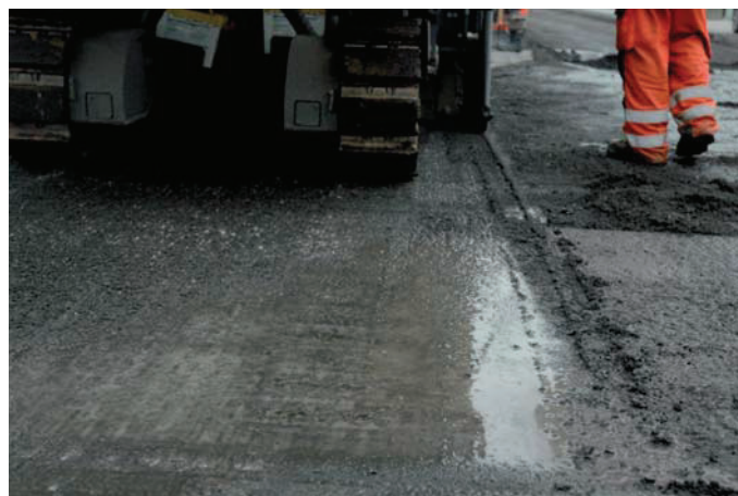
Fot. 10. Frezowanie warstwy ścieralnej nawierzchni
