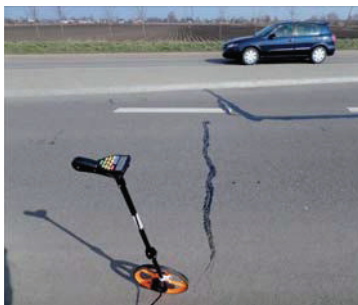
Fot. 1. Spękanie poprzeczne [7]
