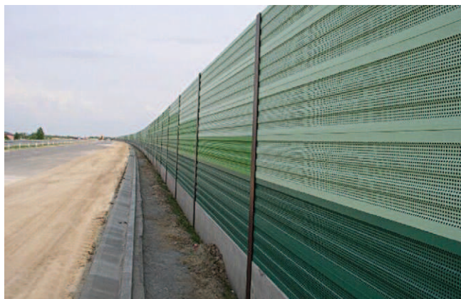
Rys. 3. Ekrany w obudowie z aluminium lub metalu
