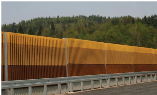
Rys. 9c. Ekran z profilowanych prefabrykatów betonowych
