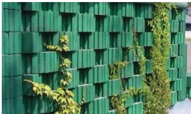
Rys. 9b. Ekran z mis betonowych
