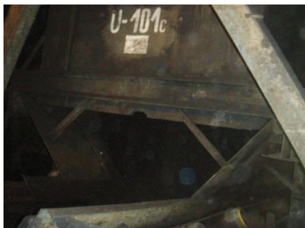
Rys. 2. Obudowany przesyp przenośnika stalowo-członowego nr U-101C [7]
