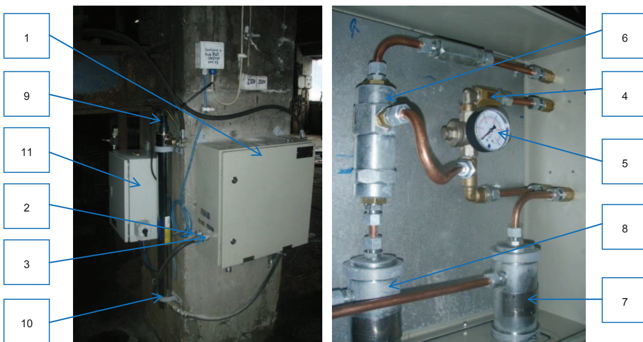
Rys. 6. Zespół zasilająco-sterujący [7]
