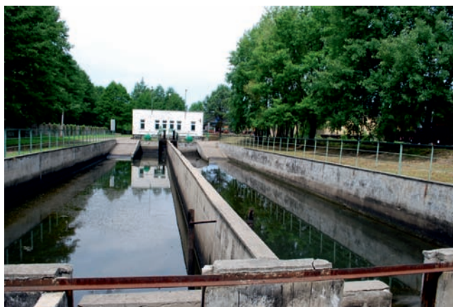
Rysunek 1 Widok istniejącego zbiornika Figure 1 View of existing tank
