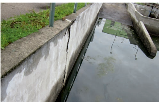
Rysunek 9 Widok ściany zbiornika po wykonanych pracach
