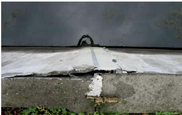
Rysunek 8 Widok z góry (z korony zbiornika) odspojenia warstwy betonu wraz z powłokami zabezpieczającymi po wykonanej naprawie
