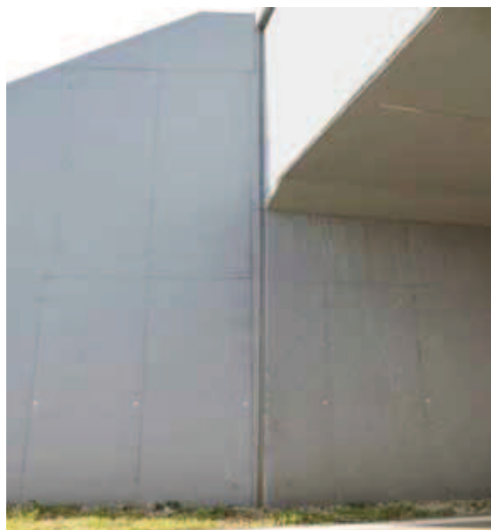
Rys. 15. Szczelina dylatacyjna między wiaduktem i skrzydlami [9] Fig. 15. Crevice dilatation between the viaduct and flanks [9]
