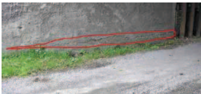
Rys. 6. Wiadukt żelbetowy – rysa pozioma na ścianie bocznej [9]
