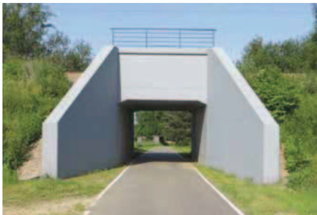
Rys. 13. Wiadukt pod torem nr 1 po przebudowie [9] Fig. 13. Viaduct under railway track no. 1 after rebuilding [9]
