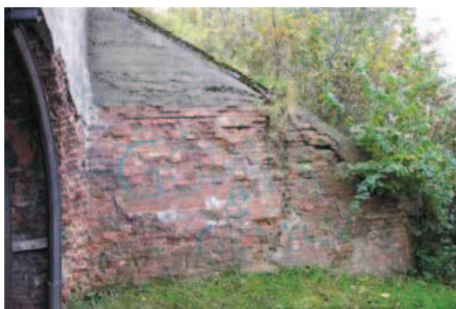
Rys. 3. Wiadukt ceglany – skrzydło południowe [9] Fig. 3. Brick viaduct – southern flank [9]
