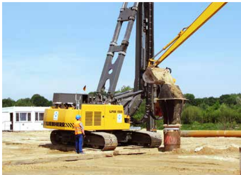
Kolumny żwirowe w osłonce geosyntetycznej
