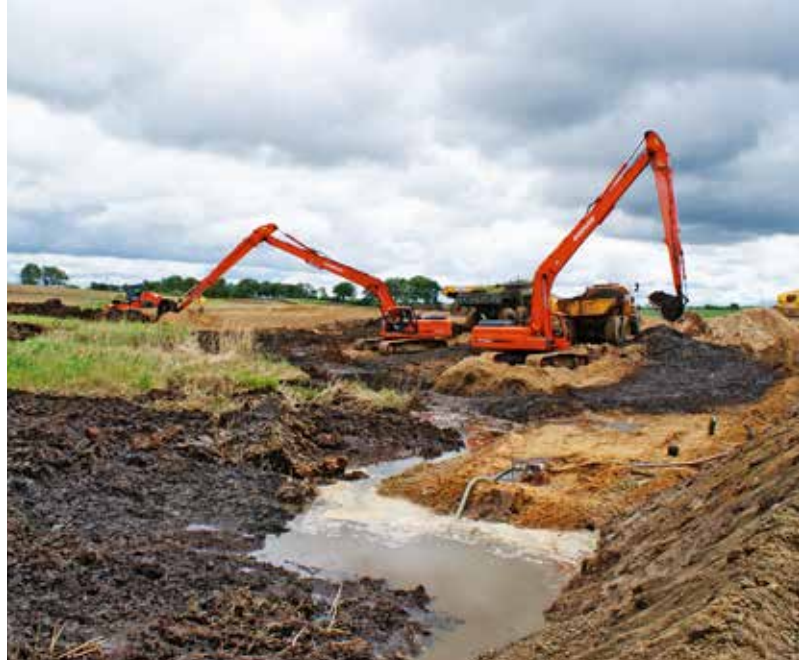
Wymiana gruntów słabonośnych
