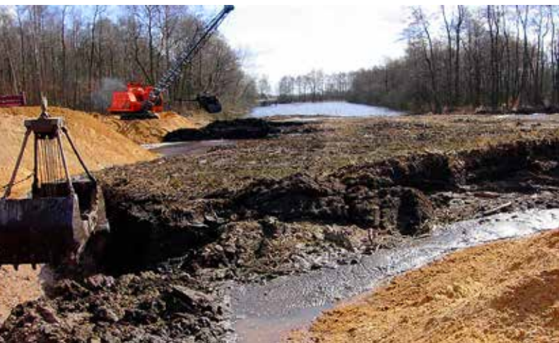
Wymiana gruntów metodą wypierania
