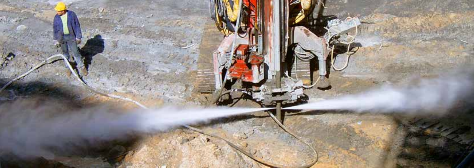
Iniekcja strumieniowa jet grouting
