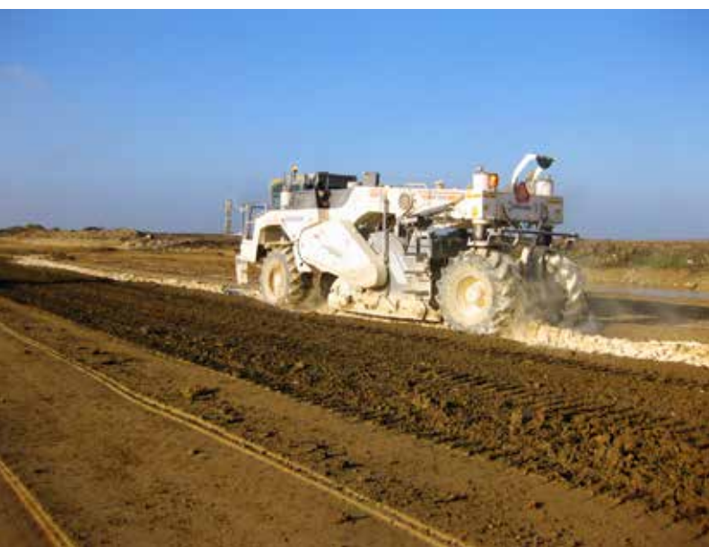
Stabilizacja powierzchniowa spoiwami hydraulicznymi
