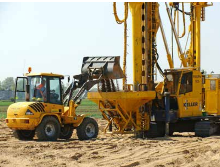
Kolumny piaskowo-żwirowe w technologii wibrowymiany
