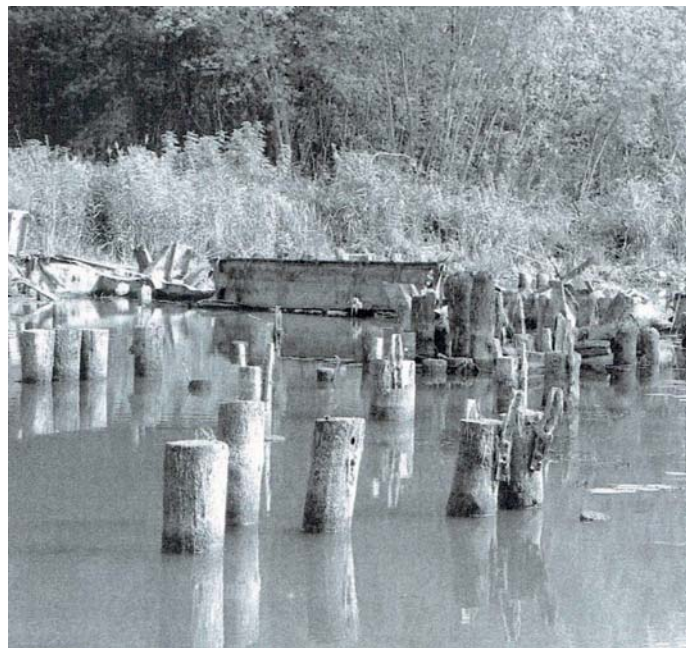
Fot. 6. Pale drewniane pozostałe po moście przez Bug w Terespolu przy Alei Marzeń [9]
