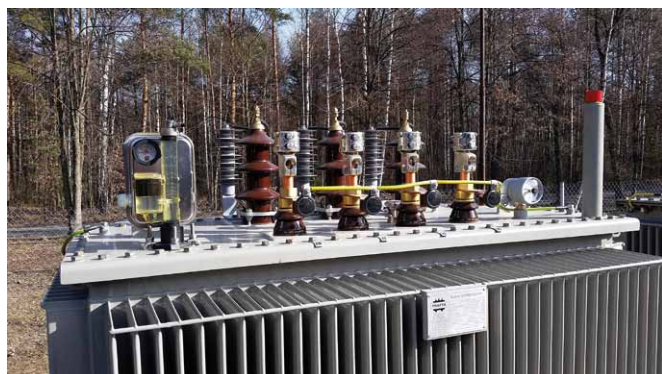
Fot. 1. Przykładowe wyposażenie dławika w wersji hermetycznej
