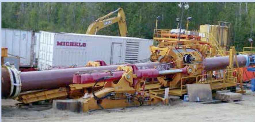
Ryc. 4. Rury gotowe do wprowadzenia [1]
