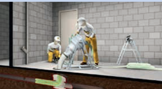
Ryc. 7. Wprowadzenie powłoki do wnętrza przykanalika [5]
