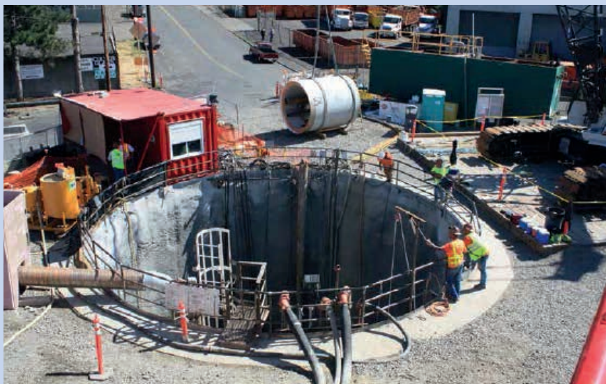
Ryc. 6. Szyb startowy urządzenia TBM [1]
