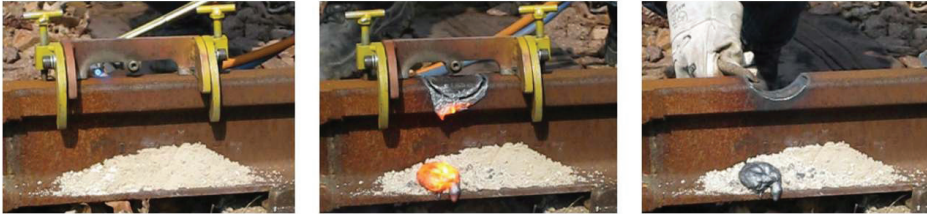
Rys. 14. Wycinanie wady w technologii THR (5)
