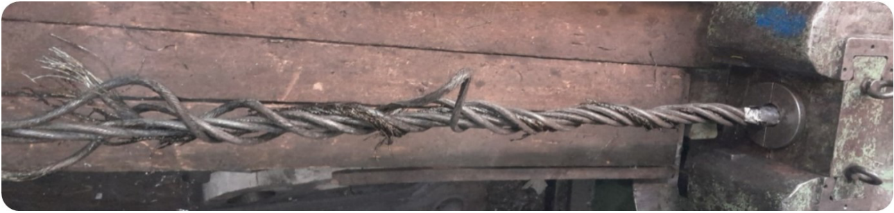
Rys. 3.1. Inspekcja MRT liny wysięgnika w systemie wielokrążkowym, dźwigu 5000T.
