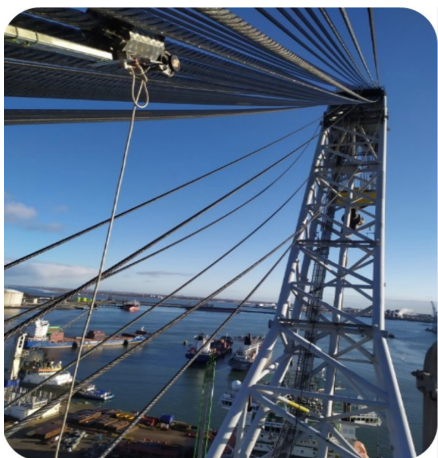
Rys. 1.2. Inspekcja MRT liny wysięgnika w systemie wielokrążkowym, dźwigu 5000T.
