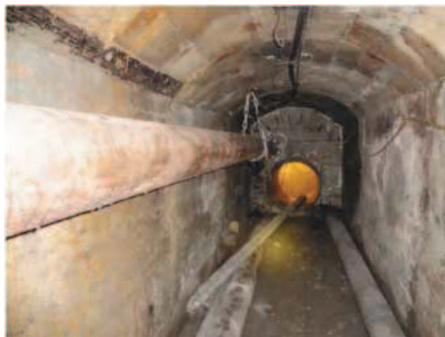
Rys. 1. Wyrobisko w obudowie murowej-betonowej okonturowujące georeaktor – od strony wlotu powietrza Fig. 1. Excavation in brick lining surrounding the georeactor – from the side of the air inlet
