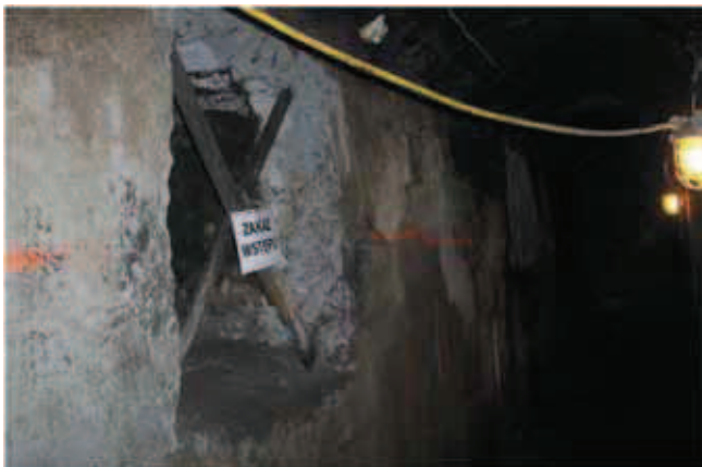
Rys. 3. Widok ociosu wyrobiska okonturowującego reaktor wraz z wlotem do kanału OI, po zatrzymaniu procesu zgazowania i wychłodzeniu reaktora
