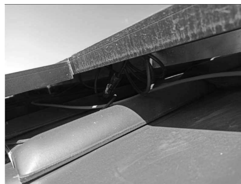
Rys. 3. Przykład złącza MC4
