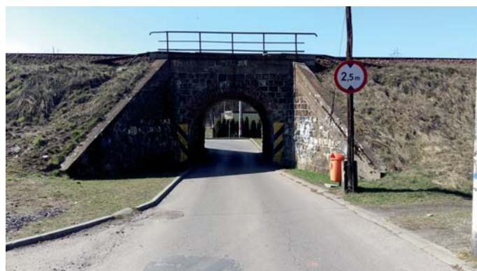
Fot. 1. Widok tunelu pod torami kolejowymi
