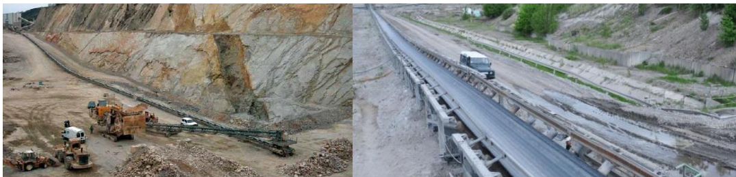
Rys. 5. Przenośnik taśmowy w górnictwie skalnym i węgla brunatnego
