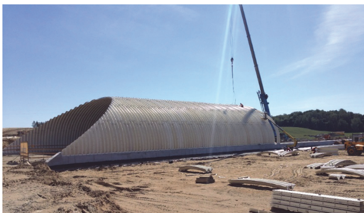
Rys. 7. Montaż powłoki z blach falistych UltraCor w Ostródzie
