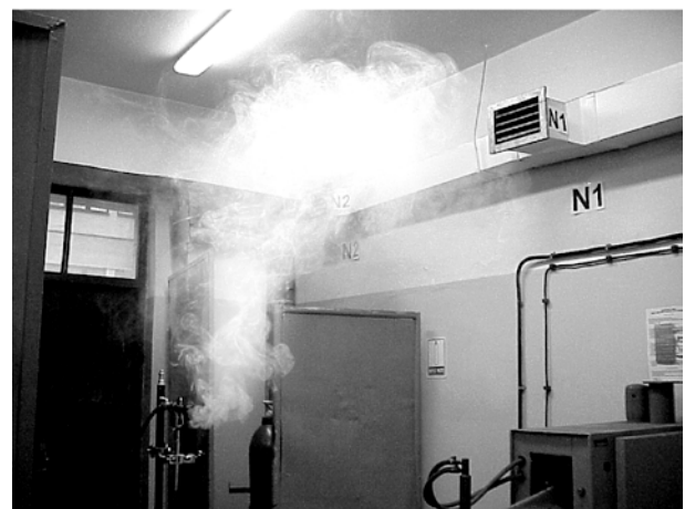
Fot. 2. Badanie przepływu powietrza metodą wizualizacji w strefie oddychania pracownika (na wysokości 1,5 m od podłogi) w środku pomieszczenia spawalni: przy czynnej wentylacji mechanicznej ogólnej nawiewnej, przy nieczynnej wentylacji mechanicznej ogólnej nawiewnej
