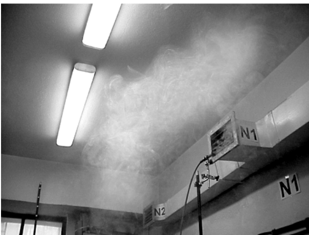
Fot. 1. Badanie przepływu powietrza metodą wizualizacji w pomieszczeniu spawalni w pobliżu nawiewnika N1 (na wysokości 2,5 m od podłogi): przy czynnej wentylacji mechanicznej ogólnej nawiewnej, przy nieczynnej wentylacji mechanicznej ogólnej nawiewnej
