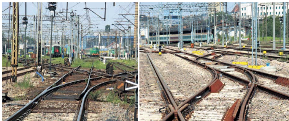
Rys. 2. Fragment torowiska stacji Poznań Główny przed i po modernizacji z nowymi przytorowymi urządzeniami sterowania ruchem kolejowym (Gawroński J., 2008)
