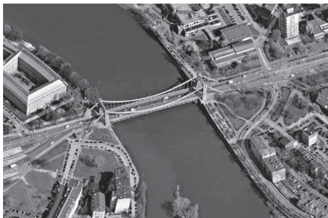
Rys. 1. Most Grunwaldzki we Wrocławiu, widok ogólny [1]
