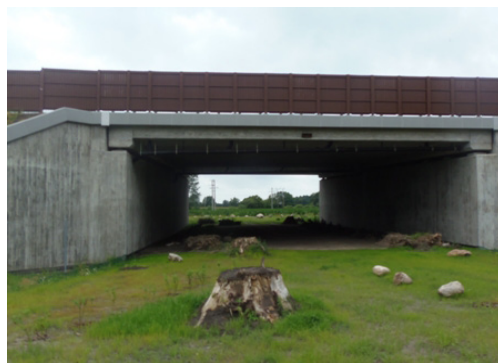
Fot. 2. Zagospodarowanie przejść dolnych.
