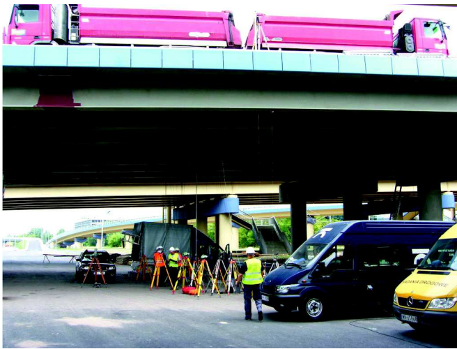
Fot. 1. Badane przęsło: widoczny sprzęt do pomiaru przemieszczeń pionowych w środku rozpiętości
