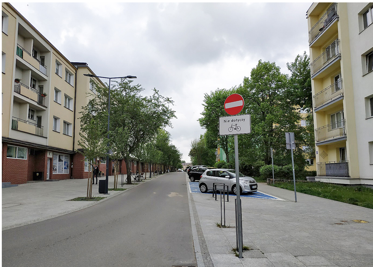
Ryc. 7. Przykład jezdni o dopuszczonym kontraruchu rowerowym – ul. Mostnika.
