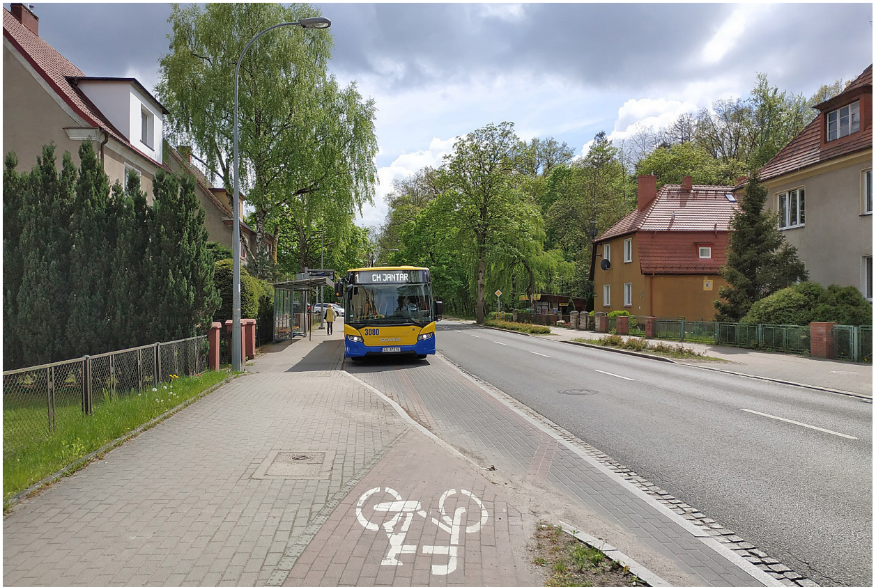
Ryc. 8. Przykład wspólnego przebiegu drogi rowerowej z zatoką przystankową, gdzie zastosowano nawierzchnię z kostki Bauma – ul. Arciszewskiego.
