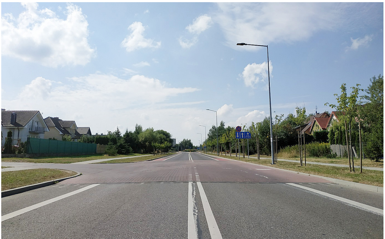
Ryc. 9. Przykład wyniesionego skrzyżowania utrudniającego przejazd pasem dla rowerów – ul. Łady-Cybulskiego.
