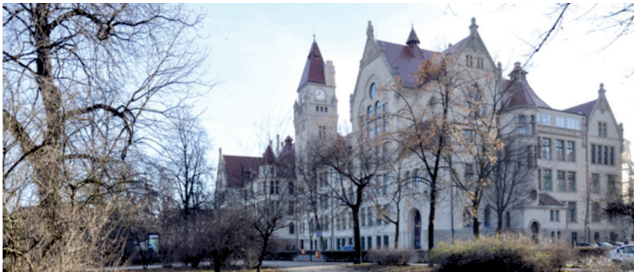
il.3. Politechnika Wrocławska: kampus E zbudowany w 1906 roku pod hasłem „solidność bez przepychu” (proj. Karl Klimm) jako kulturowe dziedzictwo i potencjał miejsca. Fot. Autor / Wrocław University of Technology: Campus E (by Karl Klimm) constructed in accordance with the motto: “solidity without pomp” as a cultural heritage of the place. Photo by the author
