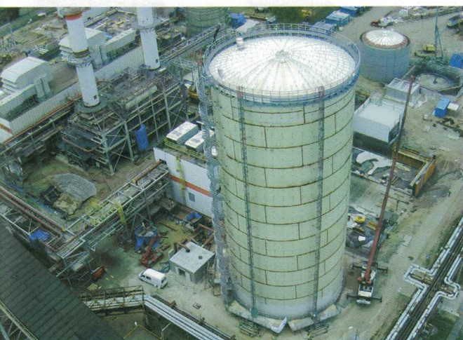
Fot. 3. Widok ogólny na akumulator ciepła, budynek kotłów odzyskniczych wraz z kominami i budynek główny (po lewej stronie)
