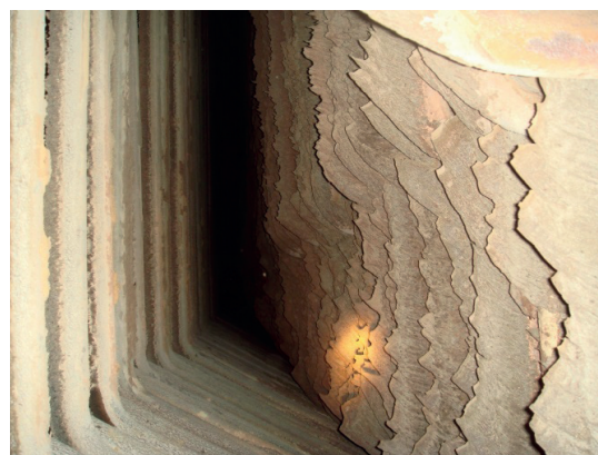
Rys. 5. Osady na powierzchniach ogrzewalnych przy współspalaniu biomasy
