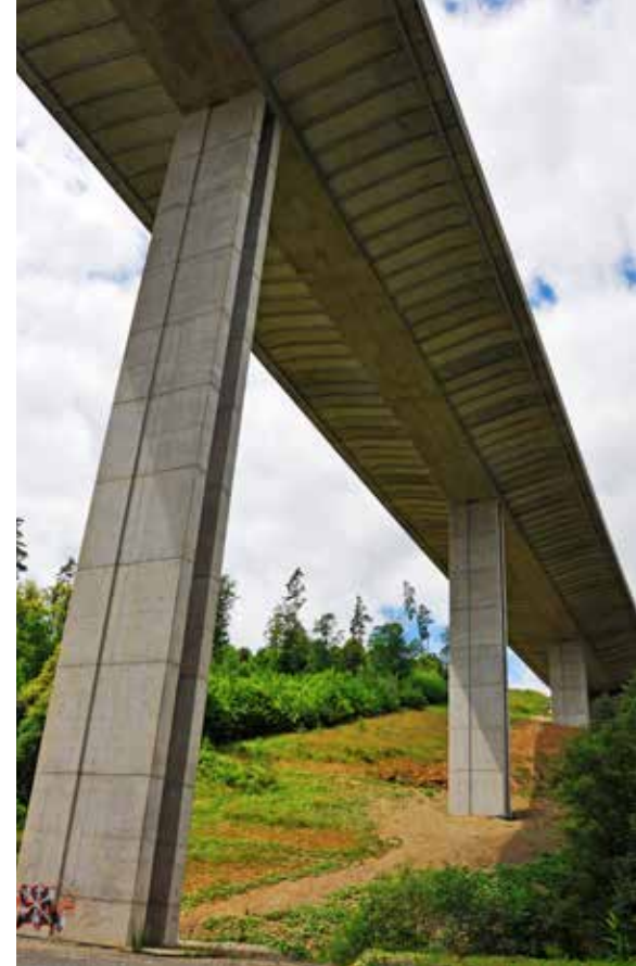
Betonowy, sprężony most autostradowy na drodze Lewocza – Spiskie Podgrodzie (obiekt nr 1)
