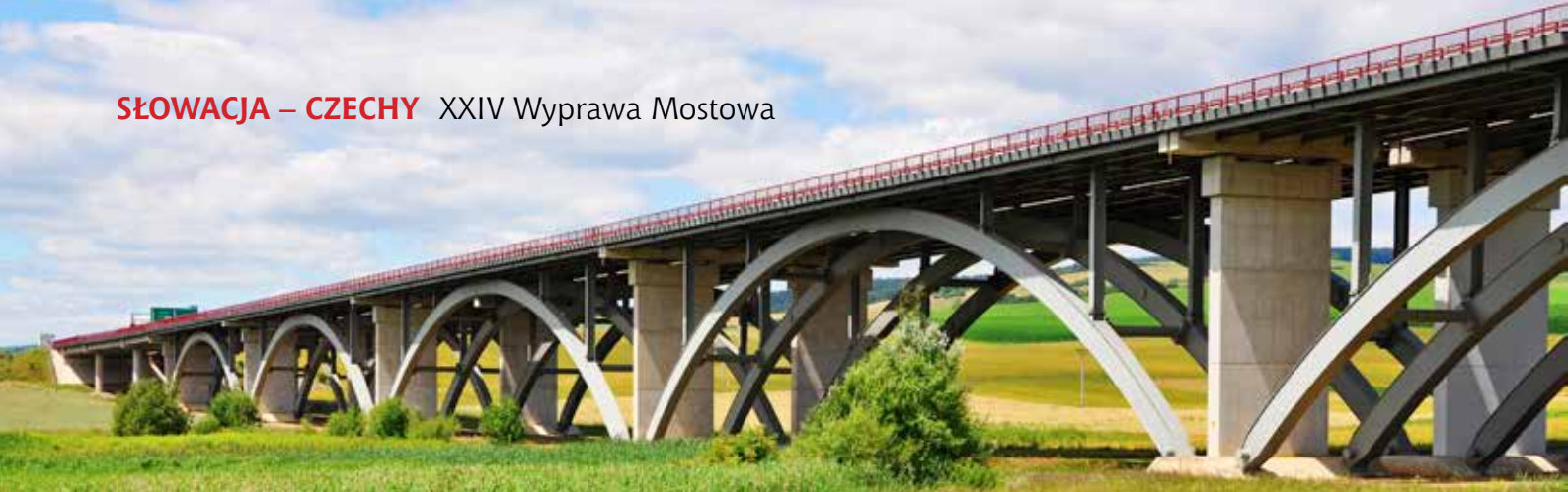
Stalowy, łukowy wiadukt autostradowy na drodze Lewocza – Spiskie Podgordzie (obiekt nr 2)
