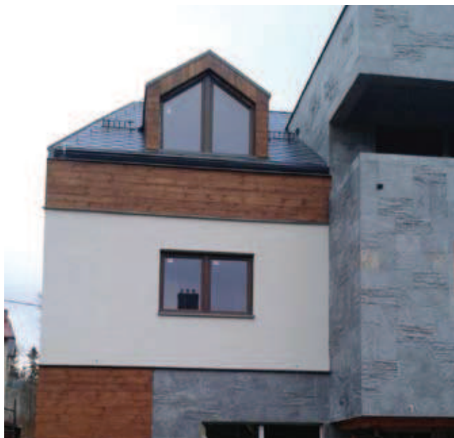
Rys. 2. Widok elewacji budynku z fragmentami okładziny drewnianej
