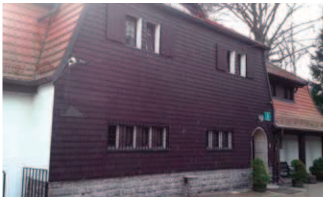
Rys. 1. Tradycyjna okładzina drewniana na elewacji
