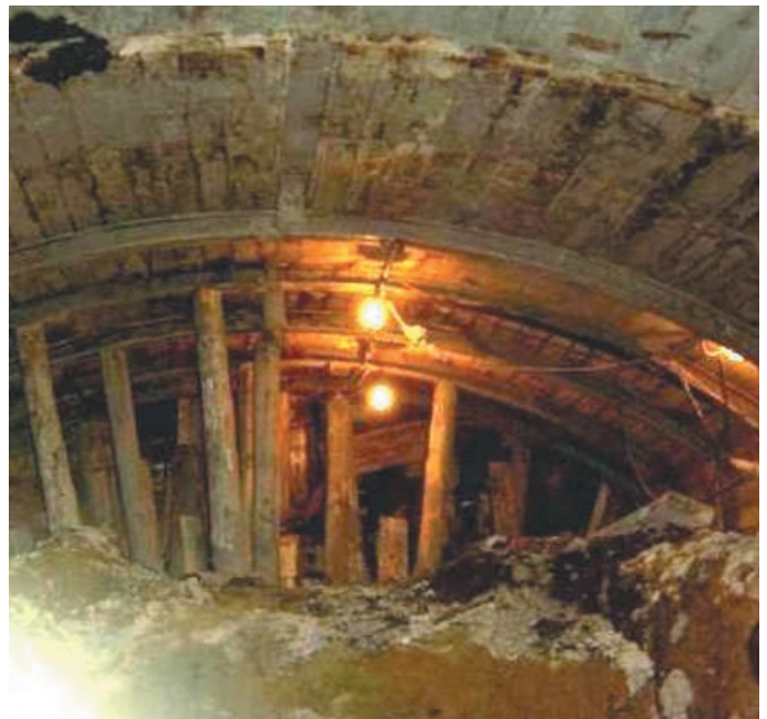
Fot. 4. Obudowa tymczasowa w kalocie Źródło: [3]
