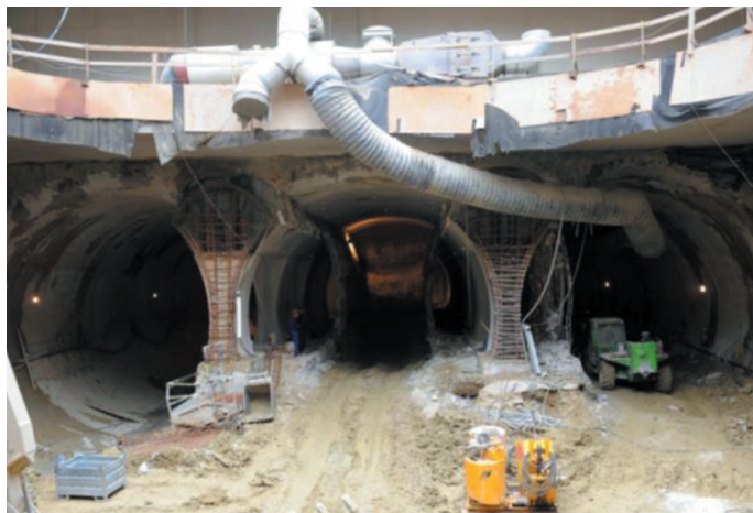
Fot. 6. Widok od strony szybu kolumnowej, trójnawowej stacji „Rakoczy Ter” w Budapeszcie Źródło: [3]
