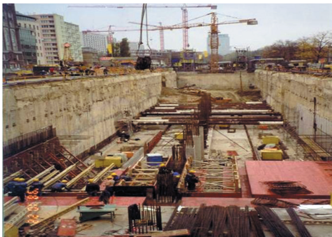
Fot. 2. Ściany szczelinowe kotwione wykopu stacji „Świętokrzyska” na I linii metra w Warszawie Źródło: [3]
