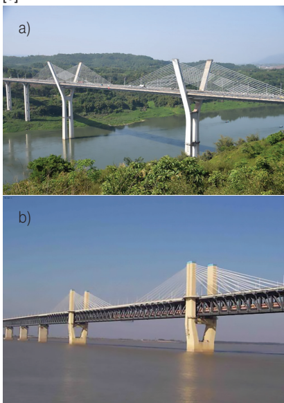
Rys. 13. Mosty „extradosed” o rekordowych w skali świata rozpiętościach przęseł: b) beton – Most Jiayue, Chiny, 250 m, 2010 rok; b) stal – most Wuhu, Chiny, 312 m, 2000 rok (dwupoziomowy drogowo-kolejowy) [3]
