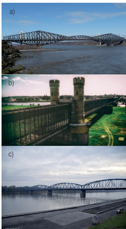
Rys. 9. Rekordowe rozpiętości stalowych przęseł kratownicowych na świecie i w Polsce: a) Pont de Quebec, Kanada, 549 m, 1917 rok (kolejowy); b) historyczny most przez Wisłę w Tczewie, 130 m, 1857 rok; c) most im. Józefa Piłsudskiego przez Wisłę w Toruniu, 132 m, 1934 rok [3]
