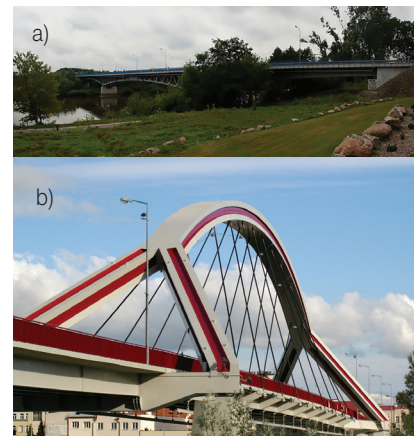
Rys. 1. a) most przez Bug w Broku, 58,00 + 3 x 69,00 m + 88,00 m + 49,00 m = 402 m, 1995 rok, główny projektant Jerzy Bąk; ( https://commons.wikimedia.org/wiki/File:Brok_most_na_Bugu_30.07.2012_p.jpg ); b) most im. gen. Antoniego Madalińskiego przez Narew w Ostrołęce, 2 x 32,00 m + 110,00 m + 32,0 m = 206,00 m, 1996 rok, główny projektant Marek Łagoda ( https://pl.wikipedia.org/wiki/Most_Madali%C5%84skiego )
