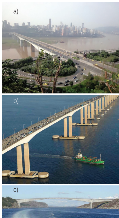
Rys. 2. Mosty o rekordowych w skali świata przęsłach belkowych: a) most Shibano, Chiny, 330 m (przęsło betonowo-stalowe – por. rys. 3., 2006 rok); b) most Ponte e Silva, Rio-Niterói, Brazylia, 300 m (stalowa część nawigacyjna), 1974 rok; c) betonowy most Stolma, Norwegia, 301 m (środkowa część o długości 180 m z betonu lekkiego), 1998 rok [3]
