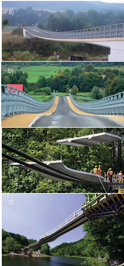
Rys. 21. Dwie rekordowe (i jedyne) kładki wstępowe w Polsce: a) i b) beton – w Lubniu, przez Rabę, 71,40 m, 2011 rok [3]; c) i d) beton – w Zagórzcu Śląskim przez Jezioro Bystrzyckie, 80 m, 2019 rok [fot. arch. Betard]
