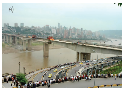
Rys. 2. Mosty o rekordowych w skali świata przęsłach belkowych: a) most Shibano, Chiny, 330 m (przęsło betonowo-stalowe – por. rys. 3., 2006 rok); b) most Ponte e Silva, Rio-Niterói, Brazylia, 300 m (stalowa część nawigacyjna), 1974 rok; c) betonowy most Stolma, Norwegia, 301 m (środkowa część o długości 180 m z betonu lekkiego), 1998 rok [3]
