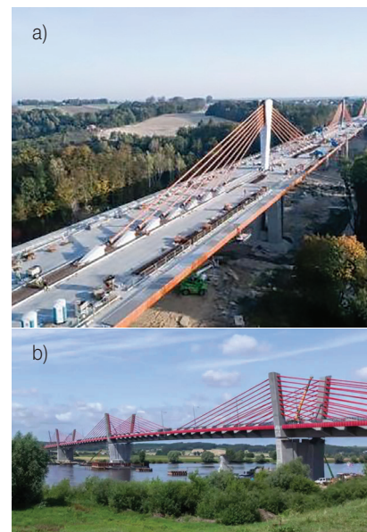
Rys. 15. Mosty „extradosed” o największych w Polsce rozpiętościach przęseł: a) beton – most w ciągu DK3 w Ostrołęce, 206 m, 2017 rok (rekord Europy); b) beton – most przez Wisłę w Kwidzynie, 2004 m, 2013 rok („wicerekord” Europy) [3]
