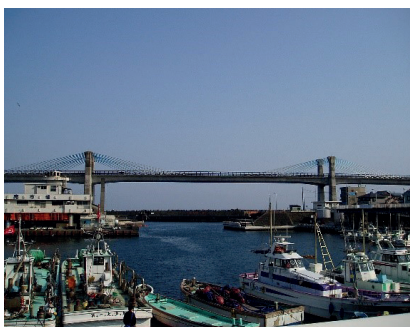
Rys. 12. Pierwszy na świecie most o konstrukcji „extradosed” – most Odawara Blueway, Japonia, l_{max} = 122 m, 1994 rok [3]
