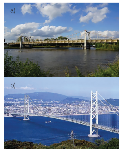
Rys. 16. Rekordowe w skali świata mosty wiszące: a) betonowy – Mariakerke, Belgia, l_{max} = 100 m, 1959 rok; b) stal – Akashi Kaikyo, Japonia, l_{max} = 1990,8 m, 1998 rok [3]
