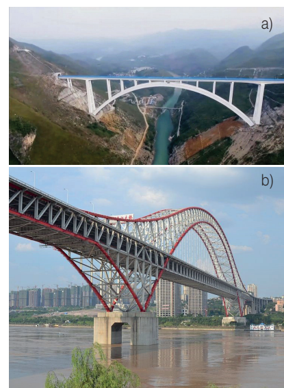
Rys. 6. Mosty o rekordowych w skali świata przęsłach łukowych; a) betonowy – most Beipanjiang, Qinglong (kolejowy!), Chiny, 445 m, 2016 rok; b) stalowy – most Chaotianmen, Chiny, 552 m, 2009 rok [3]
