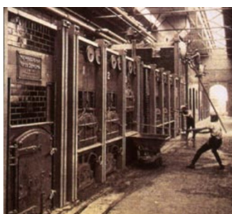
Fot. 1. Paleniska w spalarni „Descructor”. Źródło: [8] Photo. 1. Hearths in the "Descructor" incinerator. Source: [8]
