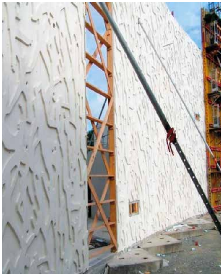
Rys. 9. Powierzchnia betonu z domieszką zmniejszającą lepkość [2]
