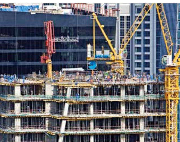
Rys. 3. Pompowanie na duże wysokości [2]
