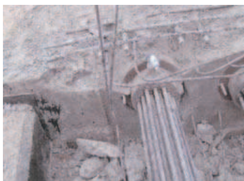
Rys. 6. Ta sama strefa zakotwień po częściowym odkuciu
