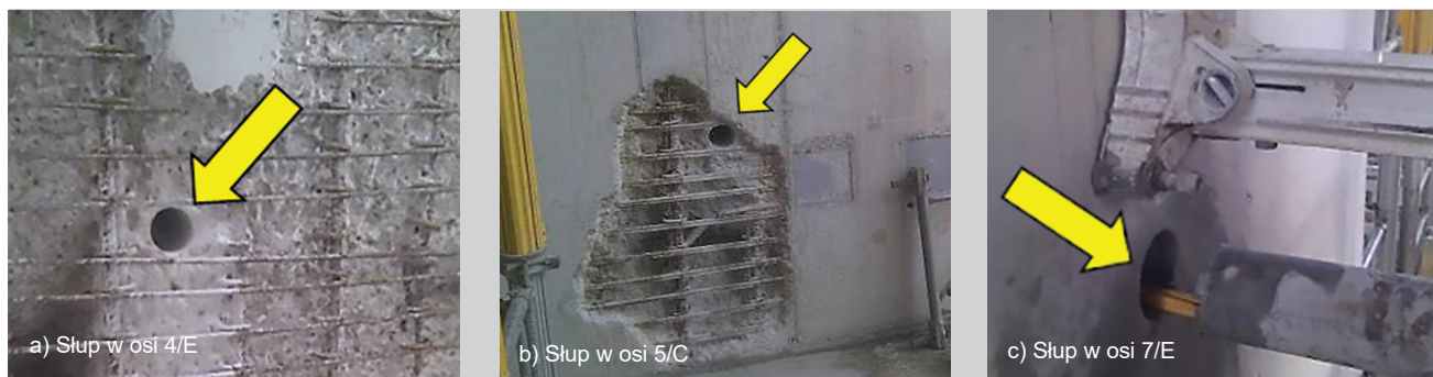
Rys. 5. Lokalizacja pobranych rdzeni betonowych
