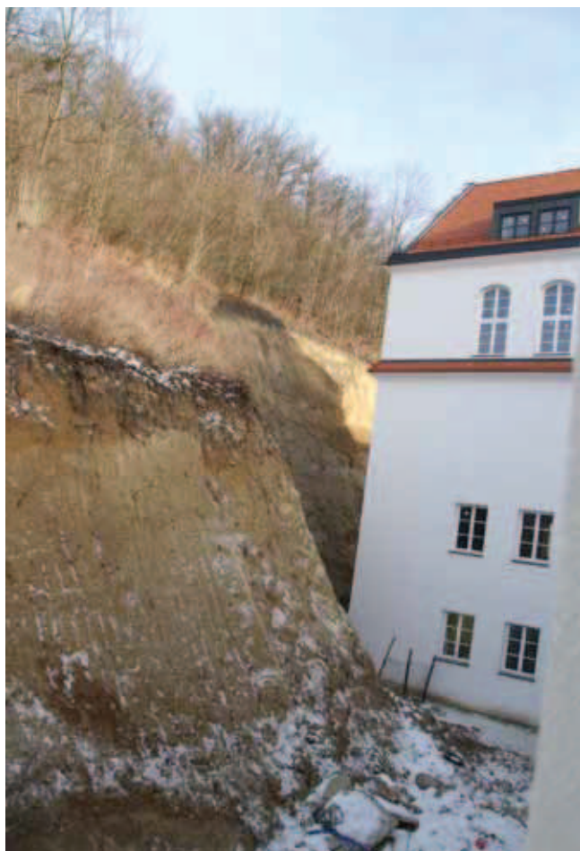
Rys. 10. Widok podciętej skarpy i jej odległość od budynku
