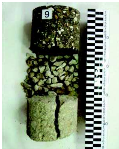
Fot. 14. Spękanie propaguje przez całą konstrukcję nawierzchni
