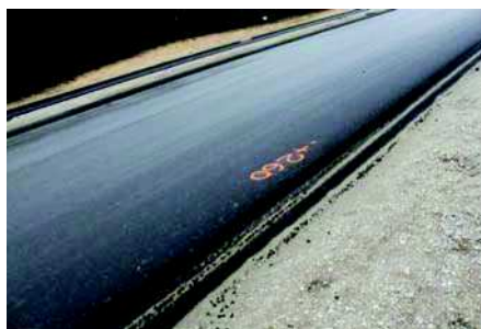
Fot. 8. Jednorodność powierzchni podbudowy asfaltowej
