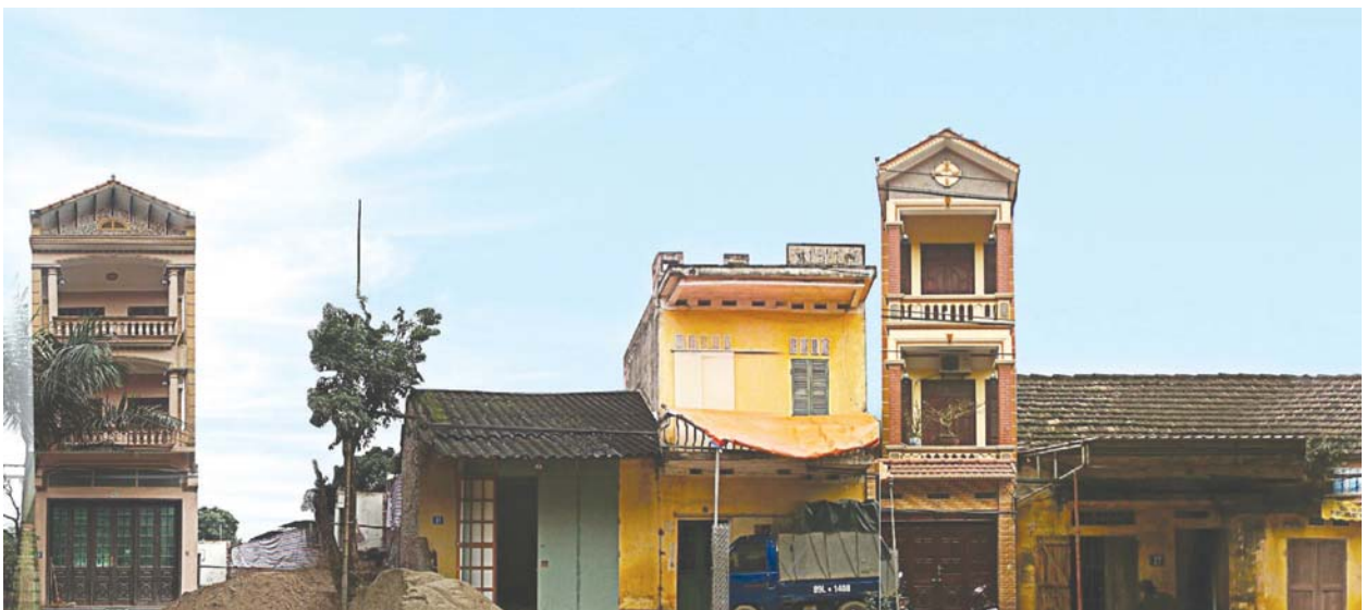
II. 7. Pho Hien. Widok ortogonalny istniejącej zabudowy nr 17-27 / Orthogonal view on houses nos. 17-27, present state (M. Zembrzuski)
