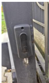
Rys. 5. Fotokomórka w bramie przesuwnej
