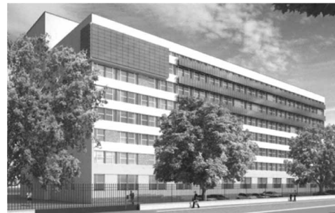
Rys. 12. Systemy fotowoltaiczne na fasadzie budynku Wydziału Inżynierii Środowiska Politechniki Warszawskiej [96]
