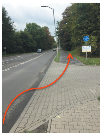
Fot. 1. Wjazd na ścieżkę rowerową z ulicy Śląskiej w Siemianowicach Śląskich poprzedzony niskim krawężnikiem o zmiennej wysokości
