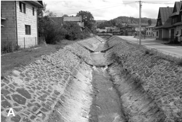
Fot. 1. Przykłady żłobów kamiennych o różnej estetyce i wpływie na środowisko przyrodnicze: (A) żłób w potoku Łopuszna w Gorcach z nieprzepuszczalnym, wyrównanym dnem, które nie może zostać zasiedlone przez organizmy denne, i szybkim prądem wody uniemożliwiającym bytowanie ryb i ich migrację na tarło; (B) żłób z terenu Szkocji o żwirowym dnie uformowanym w szereg progów i przegłębień, umożliwiający bytowanie organizmów wodnych. (fot. B. Wyźga).
