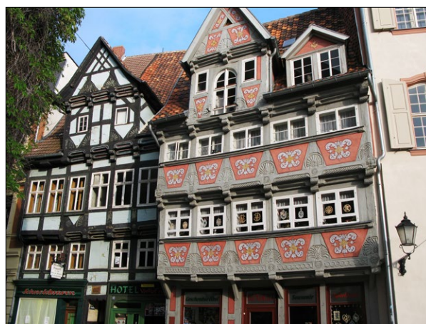
Ryc. 10. Detale elewacji zabytkowych szachulcowych kamieniczek, 2018.
