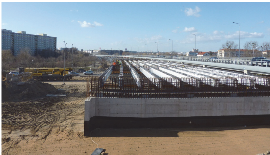
Rys. 8. Estakada Katowicka (obiekt południowy) w budowie
