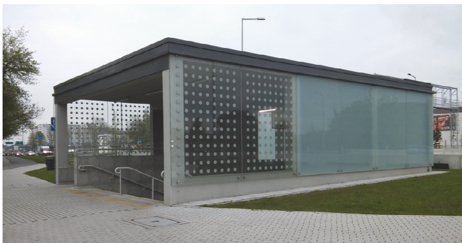
Rys. 11. Wejście do tunelu Jagiellońskiego po remoncie
