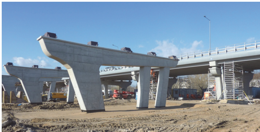
Rys. 13. Filar Estakady Katowickiej (południowej) – 5 stanowisk podłożyskowych
