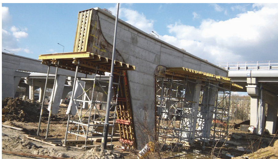
Rys. 2. Kształtowanie podpory estakady południowej przy użyciu desek
