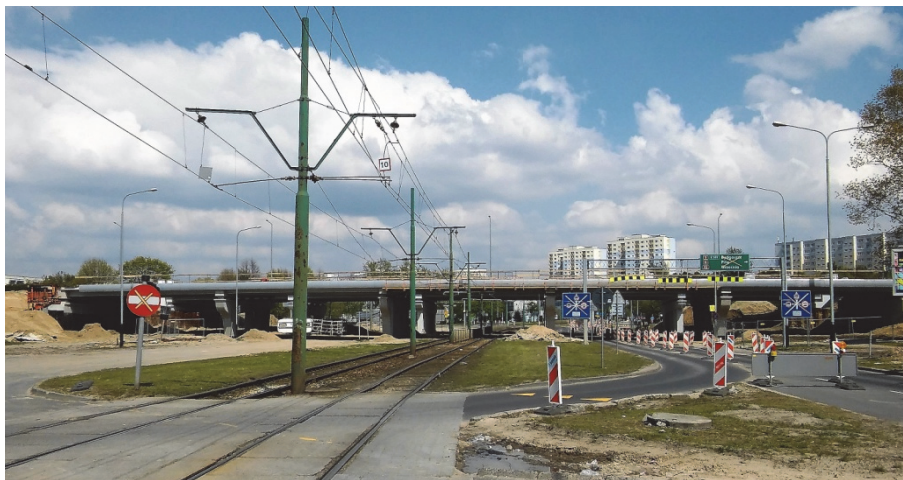
Rys. 10. Nowo budowany wiadukt nad ul. Chartowo i ul. Żegrze
