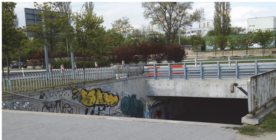
Rys. 12. Wejście do niewyremontowanego tunelu Lecha
