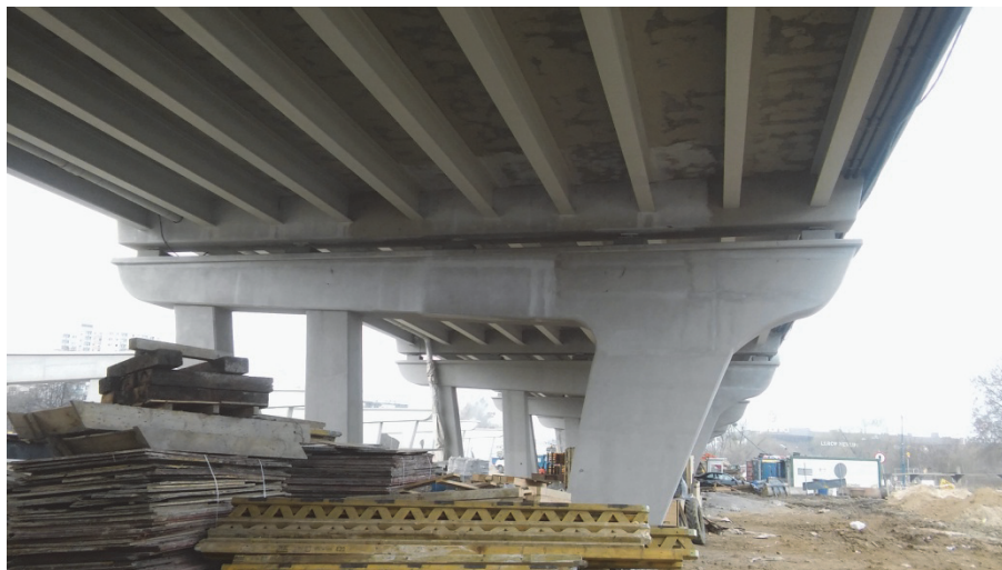
Rys. 7. Nowo wybudowana estakada północna oddana do użytku 16 lipca 2016 r
