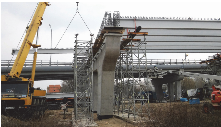
Rys. 3. Montaż belki stalowej z łącznikami sworzniowymi na estakadzie południowej (kwiecień 2017r.)
