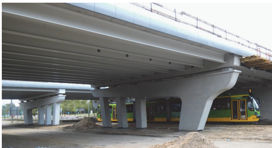
Rys. 9. Podpory dwóch osobnych obiektów nowo budowanego wiaduktu nad ul. Chartowo i ul. Żegrze
