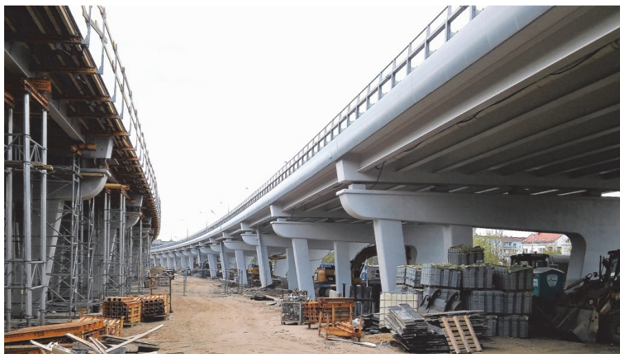
Rys. 4. Nowo budowana Estakada Katowicka (nad doliną Obrzycy) – widoczne obie estakady: południowa w budowie i północna oddana do użytku
