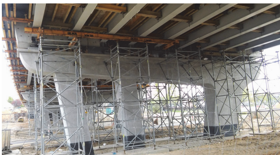
Rys. 6. Nowa konstrukcja (podpora i pomost) estakady południowej (w budowie)
