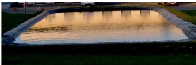
Fot. 6. Zbiornik odparowujący ( http://poradnikprojektanta.pl/zbiorniki-retencyjne-retencyjno-infiltracyjne/ 11.12.2015)
