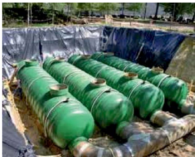
Fot. 8. Przykład zbiornika retencyjnego podziemnego ( https://encrypted-tbn1.gstatic.com/images 11.12.2015)
