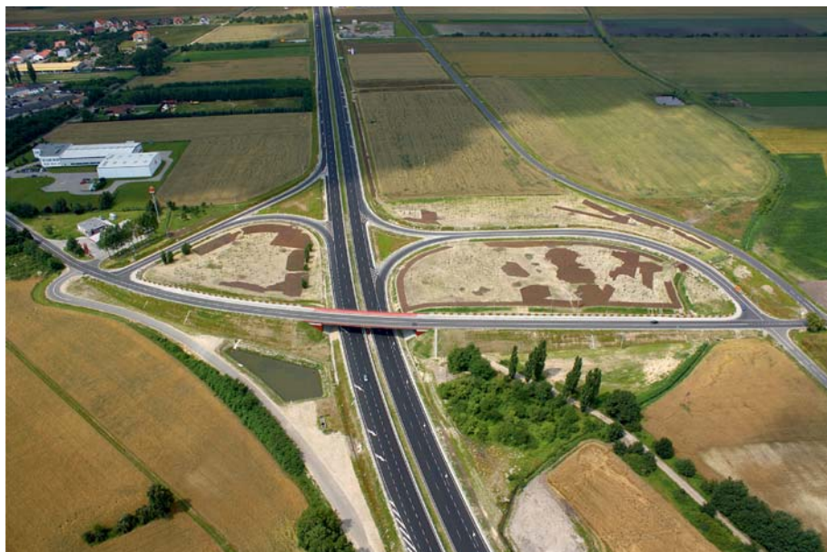
Fot. 5. Zbiornik wodny w węźle na drodze ekspresowej S11 Poznań – Kórnik (archiwum Transprojektu Warszawa, fot. Artur Gajdziński)
