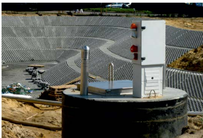
Fot. 7. Zbiornik retencyjny z przepompownią wody w centrum Poznania ( http://poradnikprojektanta.pl/zbiorniki-retencyjne-retencyjno-infiltracyjne/ 11.12.2015)
