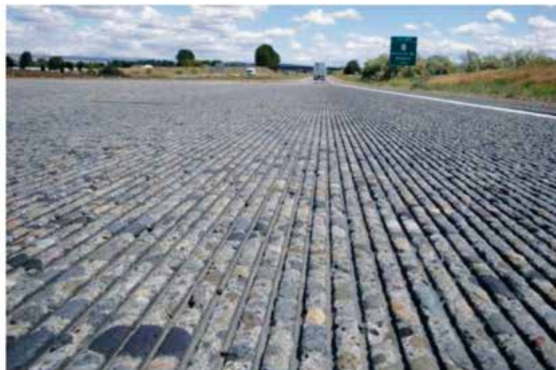
Rys. 14. Rowkowanie i szlifowanie diamentowe („diamond grinding and grooving”), [6]
