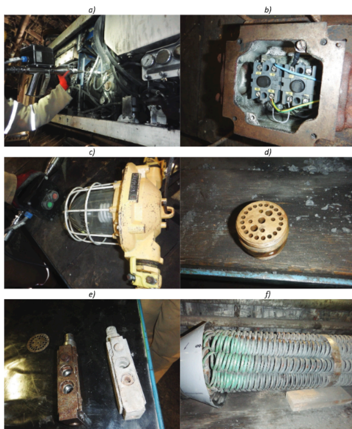
Rys. 9. Czyszczone urządzenia dołowe
