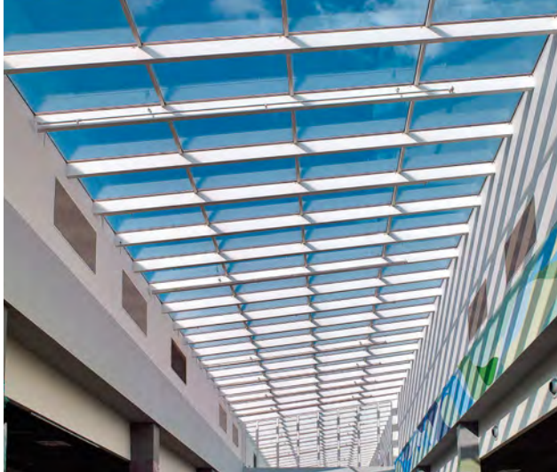
Galeria Ogród Odrzański, Kędzierzyn-Koźle
